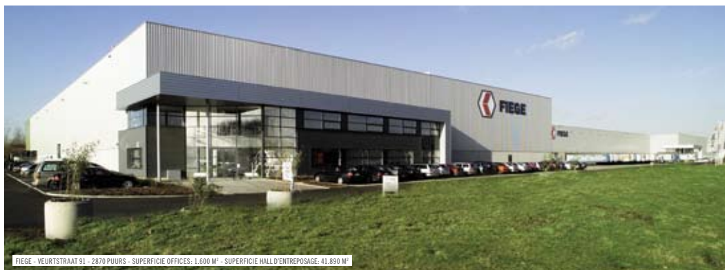
FIEGE - VEURTSTRAAT 91 - 2870 PUURS - SUPERFICIE OFFICES: 1.600 M 2 - SUPERFICIE HALL D'ENTREPOSAGE: 41.890 M 2
