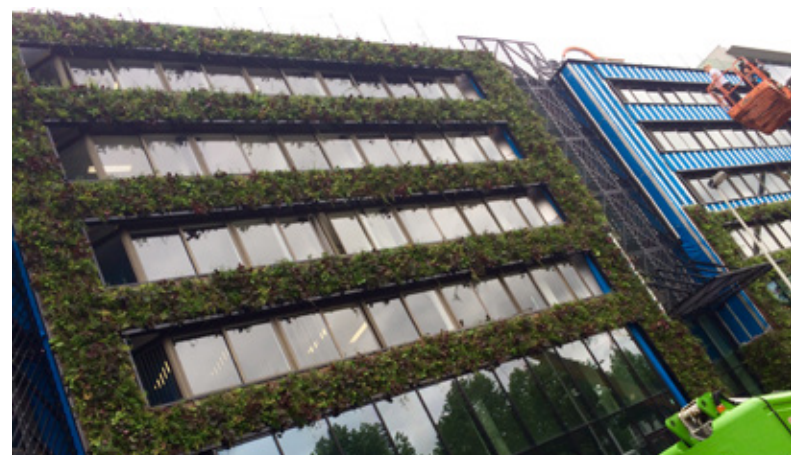
▲ Greenhouse Antwerp - Plaatsing groene gevel
