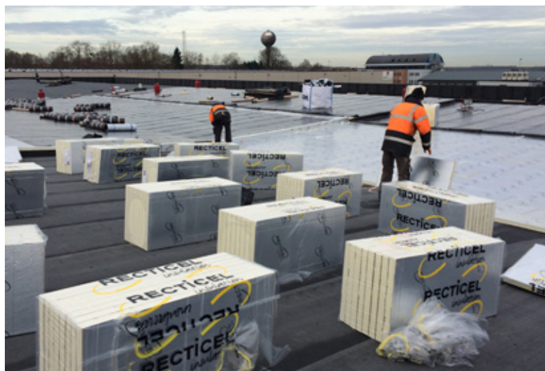
▲ Luik - Plaatsing dakisolatie nieuwbouw crossdock magazijn
